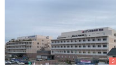
1.病院入口手前に設置された、発熱外来のプレハブ施設 2.放射線治療に力を入れる同院では、元順天堂大学主任教授の笹井先生が加わり、体制をさらに強化 3.今年4月にオープンする新館の様子。開設後は本館も改装を開始し、一層の進化を遂げる予定だ
