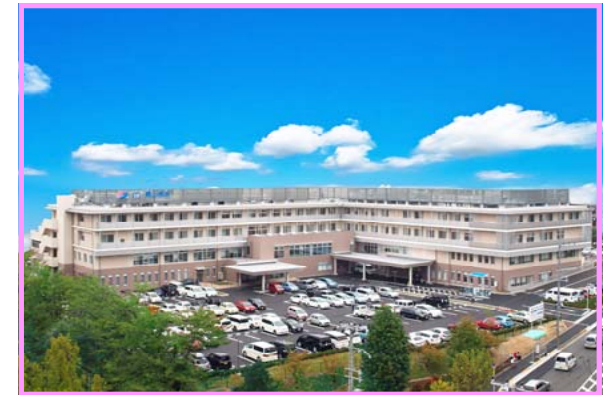
男山病院 (H26年10月竣工)
